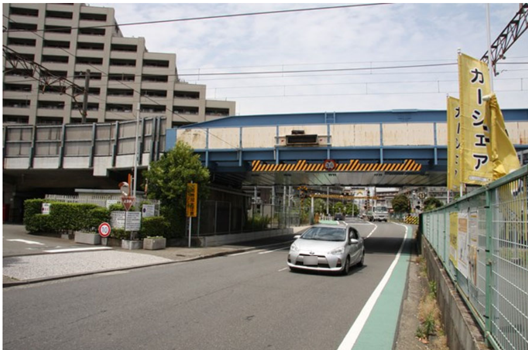
国道15号線側から
