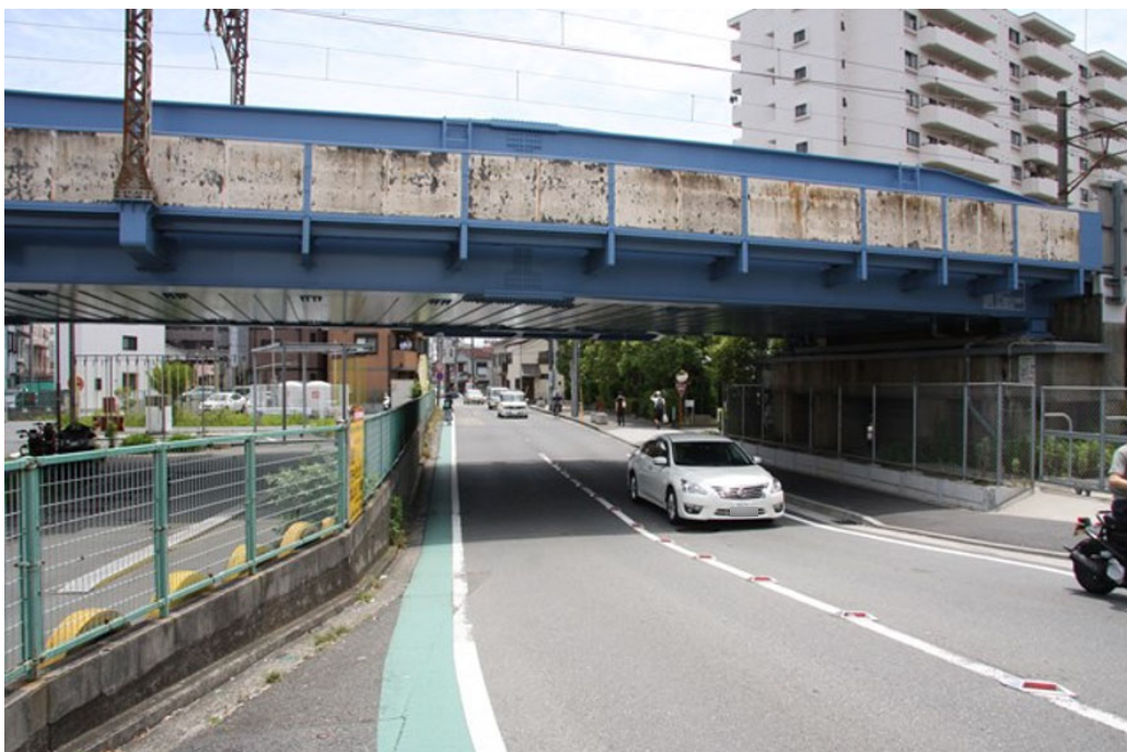
国道1号線側から
