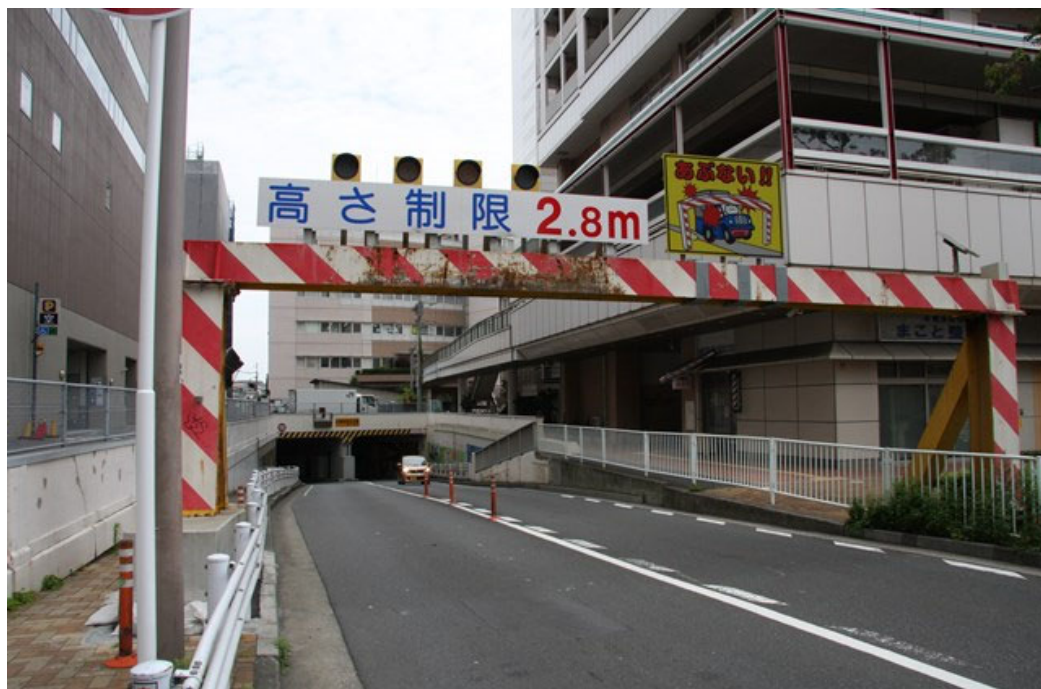
京急線側から
