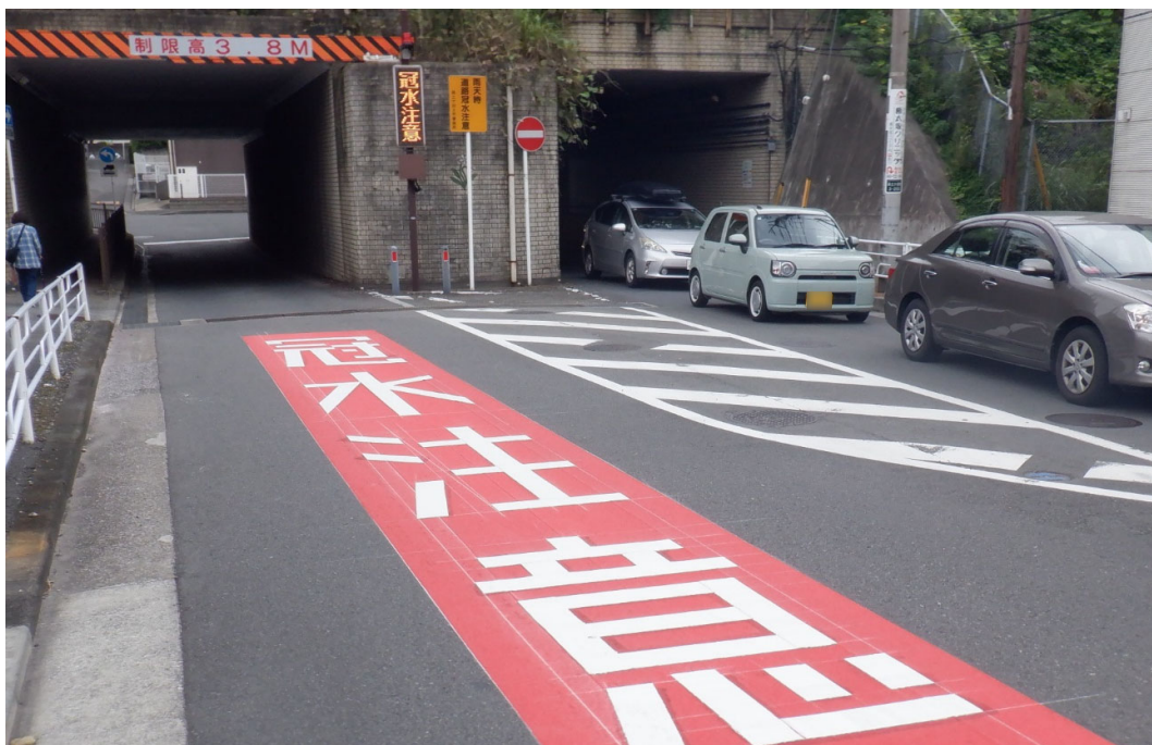
国道1号線側から
