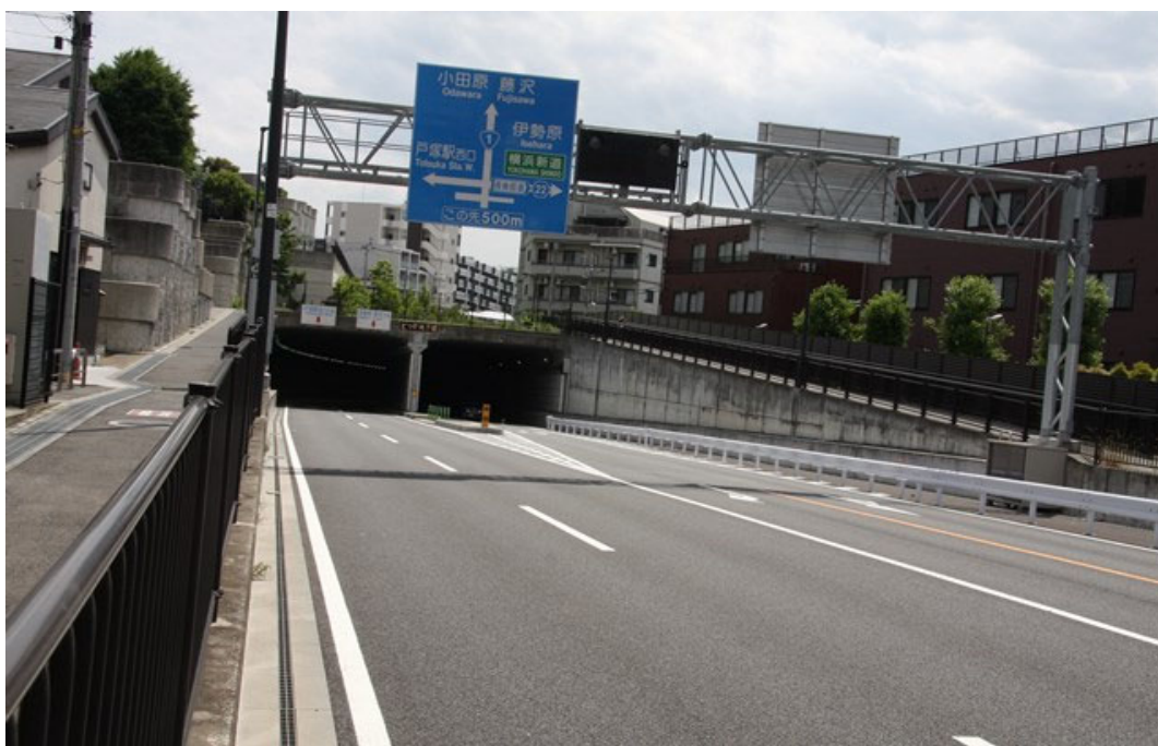
港南区方面側から
