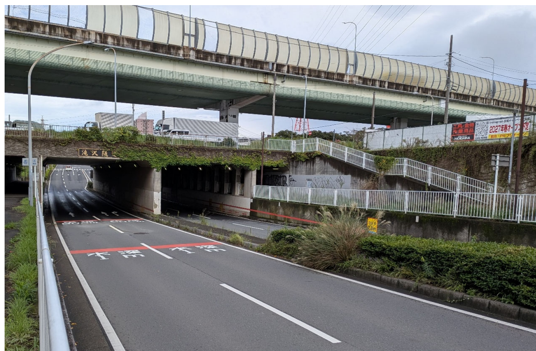
瀬谷区方面側から
