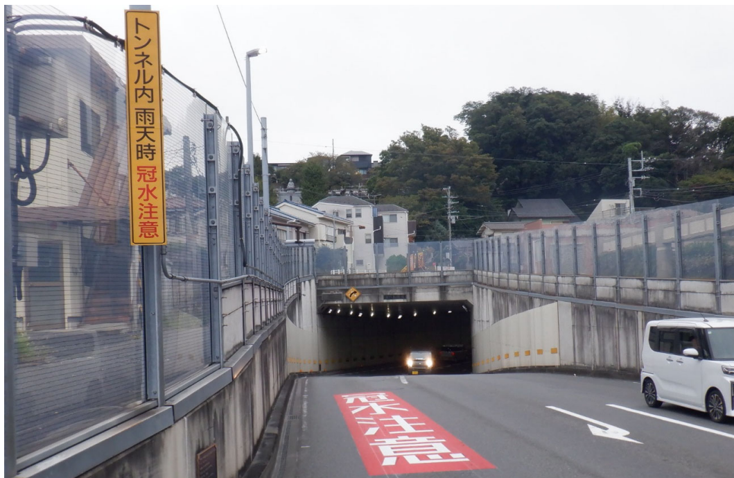
国道16号線側から
