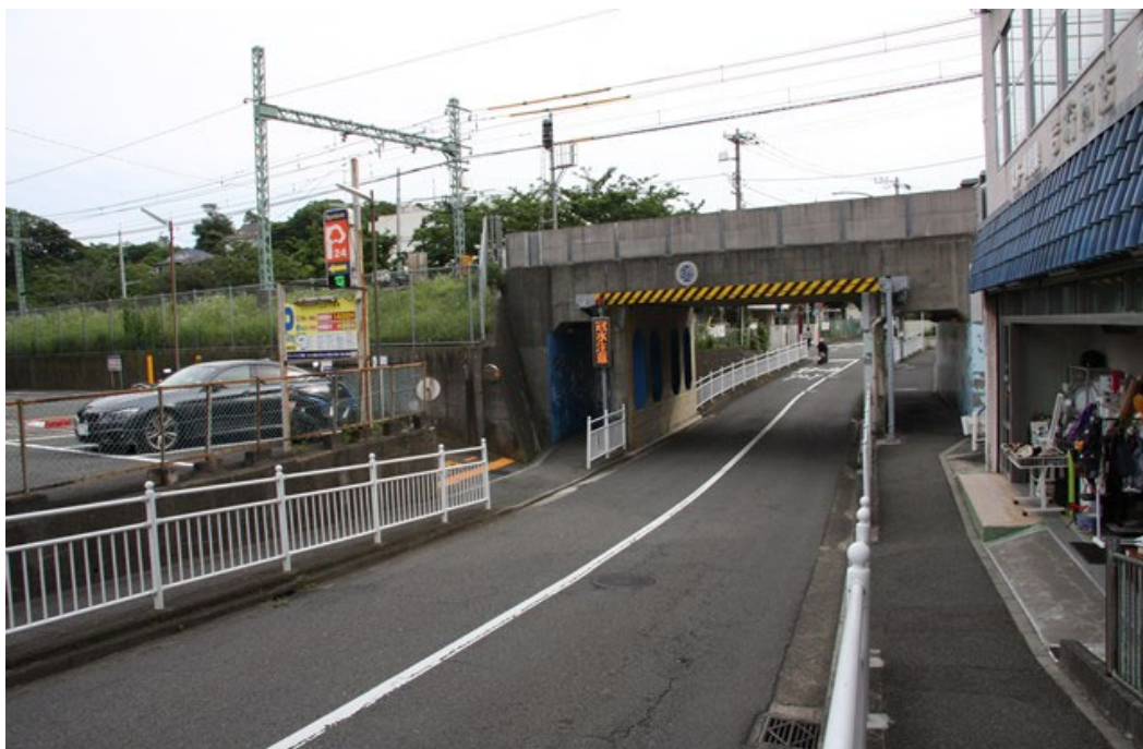
国道16号線側から
