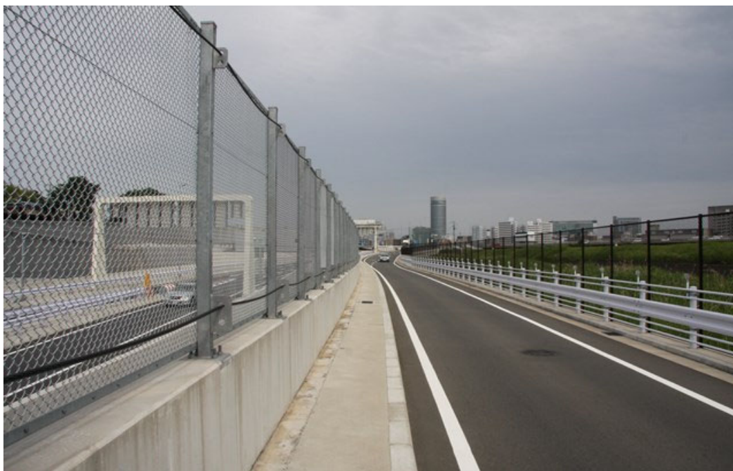
鶴見川上流側から
