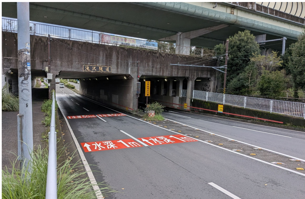
緑区方面側から
