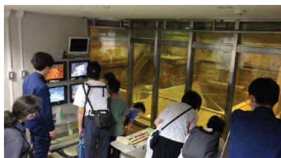
ごみクレーン操作室見学
