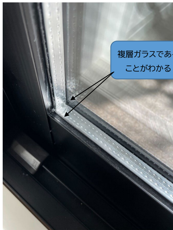
②斜めから撮影した写真
