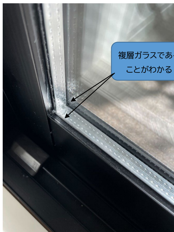
②斜めから撮影した写真
