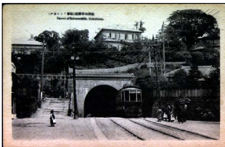
*麦田トンネル(絵葉書『横浜山手桜道 (電車ノトンネル)』より) (発行年不明)(横浜市中央図書館所蔵) 元町から桜道下(現在の麦田)をつなぐ全長約 260m(貫通当時)のトンネル。市電にとってはじめてのトンネル工事であり、1910(明治 43)年 11 月に開始された。貫通させたときの工事関係者の喜びようは、大変なものだったという。
