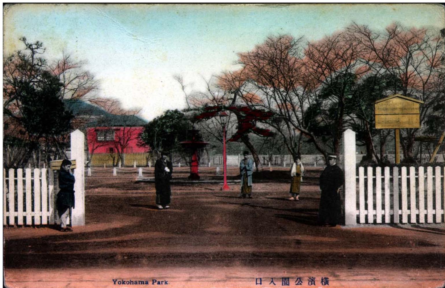
震災前：絵葉書「横浜公園入口 Yokohama Park.」
