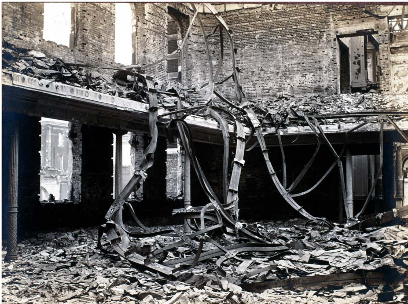
震災：紙焼き写真「横浜記念会館」（『横浜震災被害写真帖』所収）
