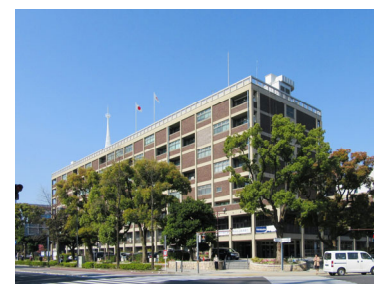
旧横浜市庁舎行政棟
