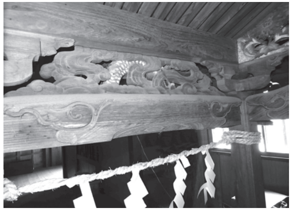
7 坂本第六社本殿 正面庇 虹梁と中備の見返し
