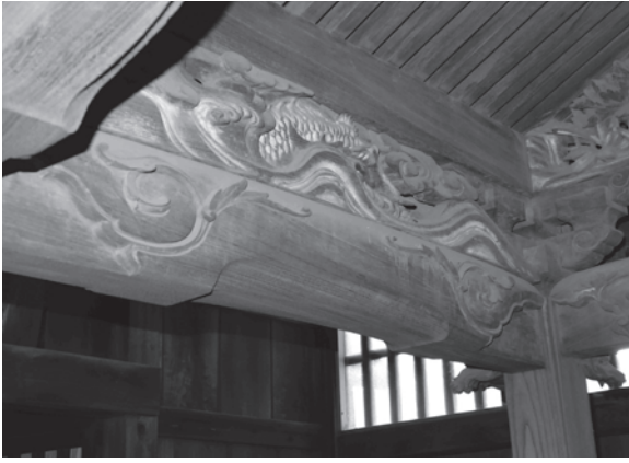
14 松尾神社本殿 庇虹梁見返し
