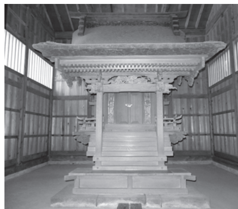
4 篠塚八幡社本殿 正面全景
