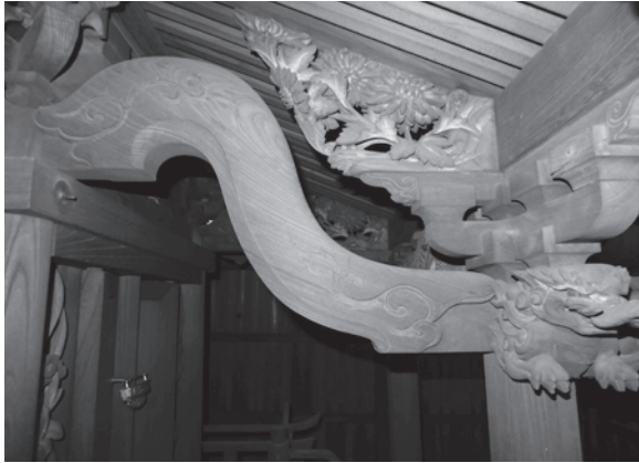
13 篠塚八幡社本殿 庇側面
