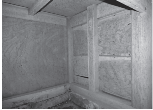
10 篠塚八幡社本殿 内部（身舎側面と背面）
