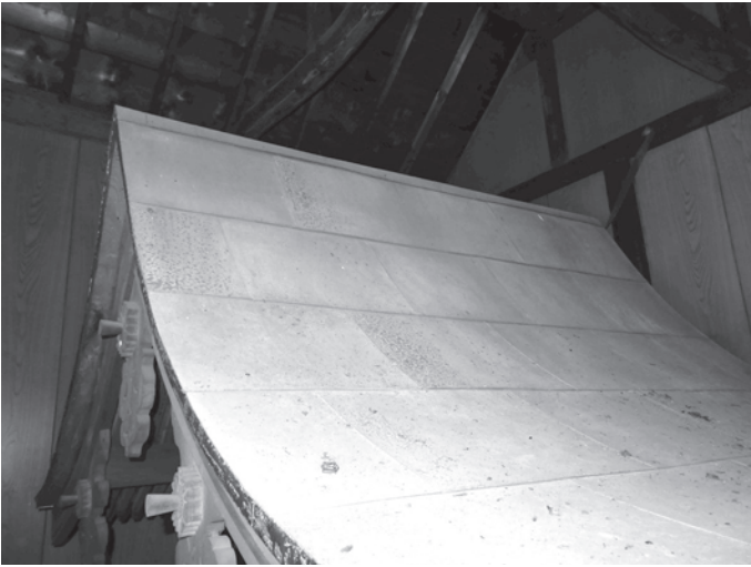
4 坂本第六社本殿 鉄板一文字葺屋根の詳細
