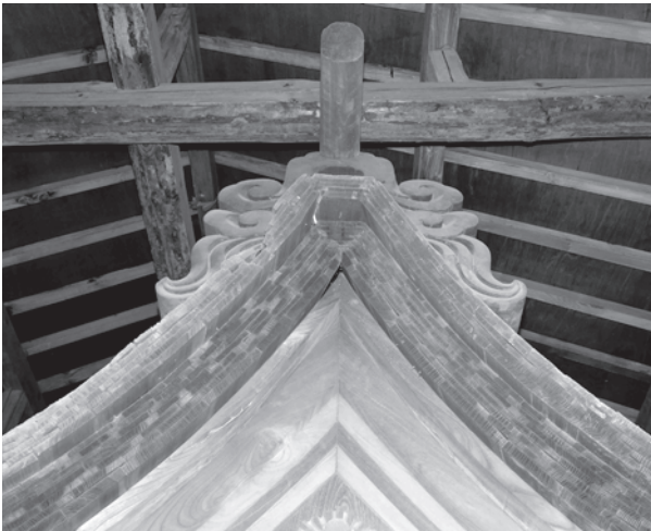
19 篠塚八幡社本殿 軒付拌み部分と鬼板・樋棟 柿葺屋根の
