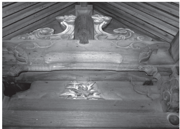
11 坂本第六社本殿 身舎中備および妻組(西側面)
