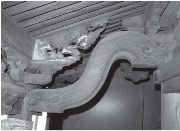
8 坂本第六社本殿 庇の海老虹梁・手挟と身舎組
