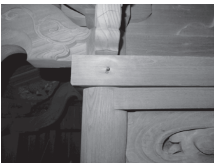
22 篠塚八幡社本殿 身舎内法長押金具痕跡
