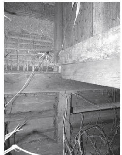
32 如来堂床下 (須弥壇と脇仏龕内部) 中央の束柱は須弥壇上端で切断されている。元は仏龕柱であったと思われるが、当初まで遡るか否かは確認できない。
