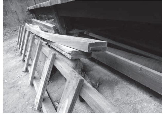
12 如来堂背面軒下に保管されている旧如来堂敷居と思われる部材
