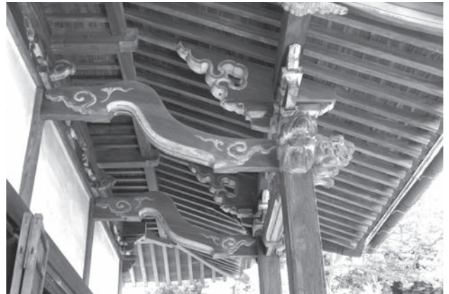
4 如来堂向拝側面見上げ 向拝柱と如来堂本体柱は海老虹梁で繋ぎ、向拝軒に手挟を配する。これらの絵様や彫形も 18 世紀後期頃の様式を示している。なお、屋根は本来茅葺きであったが、昭和 30 年頃に銅板葺に改修したという。その際に軒回りもすべて造り替えているらしい。本体軒は出桁造形式であるが、部材は新しいため旧形式に倣って新造したと思われる。
