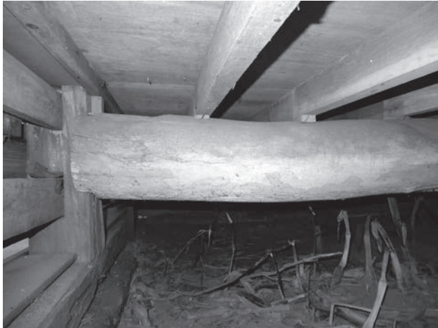
29 如来堂床下 (正面の大引と柱足元) 外周部の柱は延べ石礎石上に土台を配して立てる土台建であるが、この工法が当初形式なのか否かは現時点では明確ではない。
