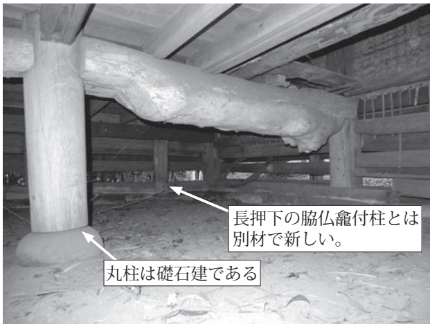
31 如来堂床下 (内部丸柱と背面柱を繋ぐ大引) 床板と根太はほぼ新材に取り替られているが、須弥壇下と脇仏龕下については古い床組が残っている。須弥壇下は床板の多くが取り外されている。
