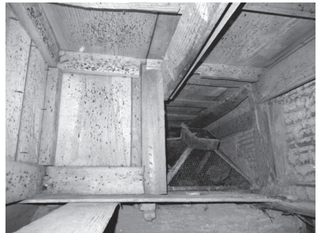
32 如来堂床下 (須弥壇と脇仏龕内部) 中央の束柱は須弥壇上端で切断されている。元は仏龕柱であったと思われるが、当初まで遡るか否かは確認できない。
