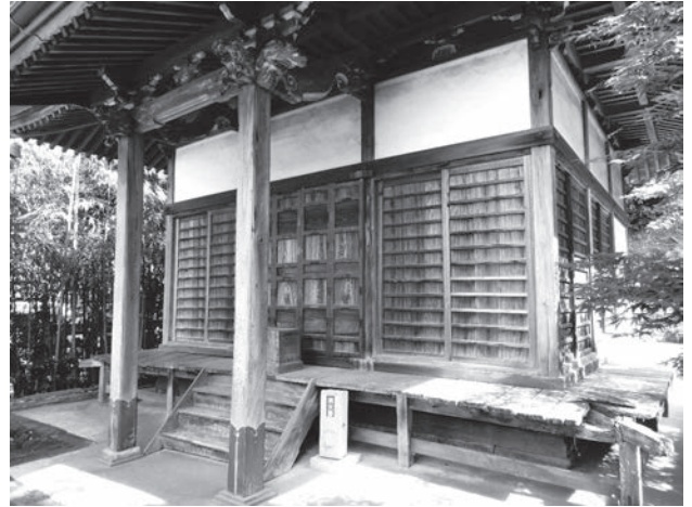
2 如来堂正側面（北西から見る） 如来堂は境内南西方の谷戸奥のやや高い場所に北面して建つ。桁行三間・梁行三間（ともに 18.6 尺）、宝形造・銅板葺屋根で、正面中央一間に向拝を設ける。
