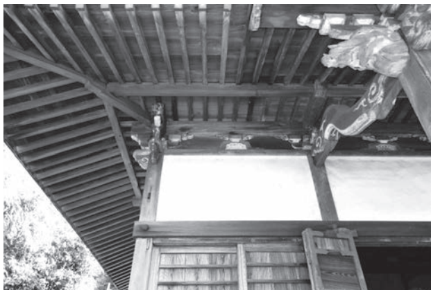
5 如来堂正面脇間の軒見上げ 頭貫木鼻と臺股の絵様と彫形はやはり 18 世紀後期頃の特徴を示す。出桁造の内側部分に垂木割と同じ根太を掛けているが、こうした形式は珍しく、軒回りを造り替えたときに採用したものであろう。
