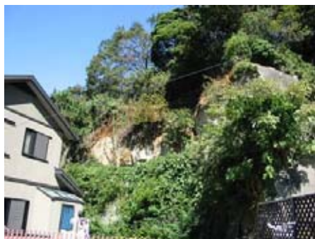
住宅にがけ崩れ
