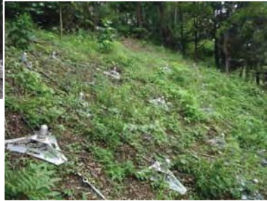
生物多様性にも配慮した防災や安全性の 対策工事を行った法面 (保土ヶ谷区／川島特別緑地保全地区)
