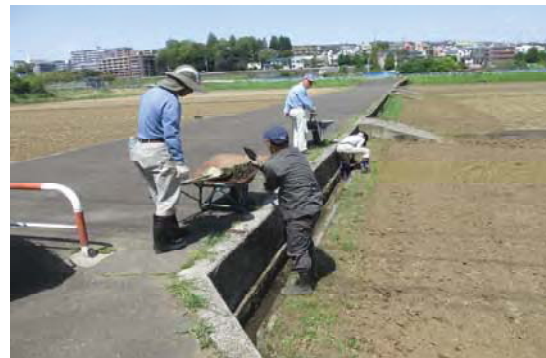
水路の維持管理作業(緑区いぶき野)
