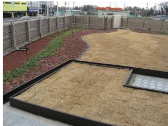
【写真】 地域で緑化計画を策定し緑化した 公共施設の屋上緑化
