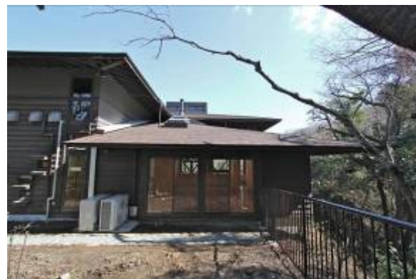
【写真】自然観察センター増築箇所
