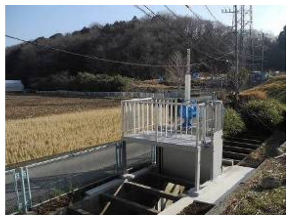
【写真】水田用水路の堰改修 (戸塚区、熊の堂水利組合)
