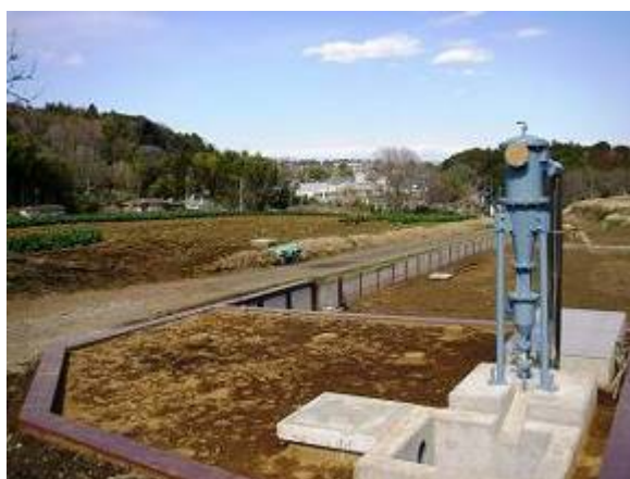
【写真】井戸及び配管整備 (緑区、向原地区畑地かんがい組合)
