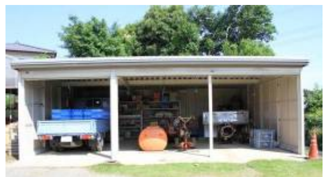
【写真】農業機械格納庫(泉区)
