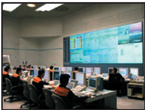
いろいろな情報を見るための画面がある指令室
