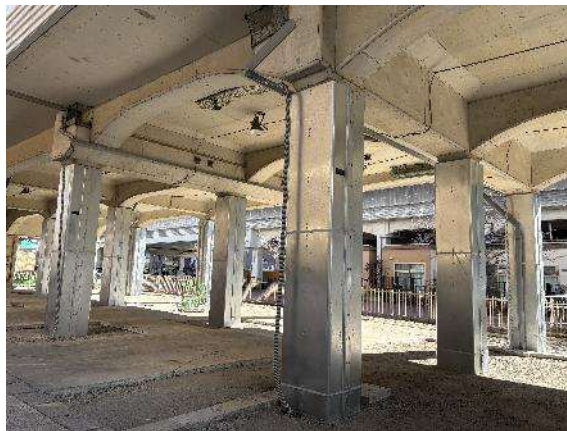
耐震補強状況（高架部）
