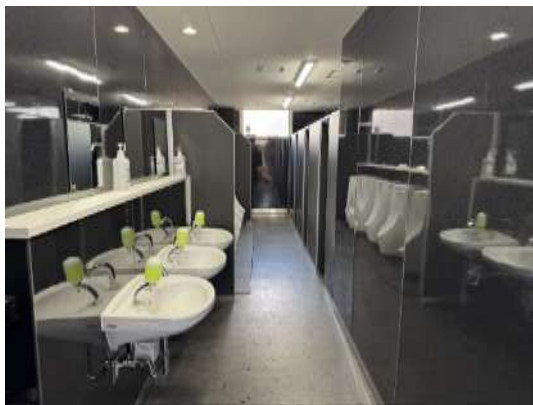
港南営業所 トイレ改修
