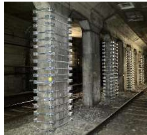
耐震補強状況（開削トンネル部）
