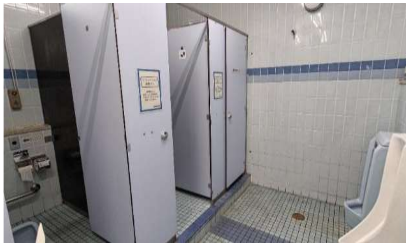
〈上永谷駅 現況〉
