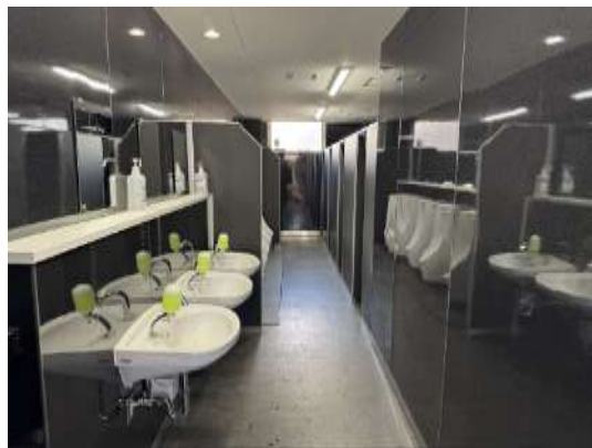
港南営業所 トイレ改修
