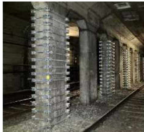
耐震補強状況（開削トンネル部）
