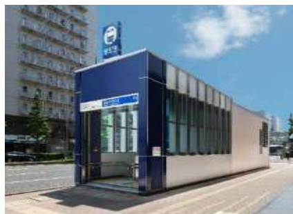
新横浜駅第10出入口 (令和6年度完成)
