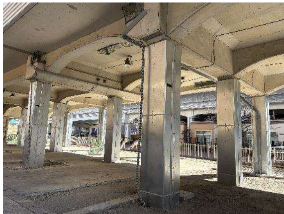
耐震補強状況（高架部）
