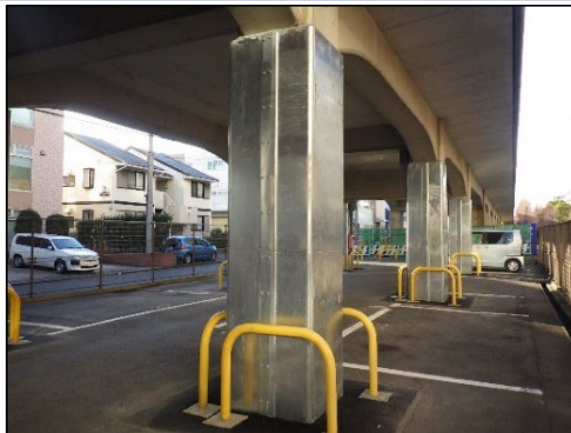
震災で損傷した高架橋柱（提供：仙台市） （剥落の恐れがある表面を修復途中で落とした状態）
