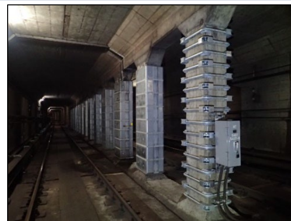
耐震補強状況（開削トンネル部）
