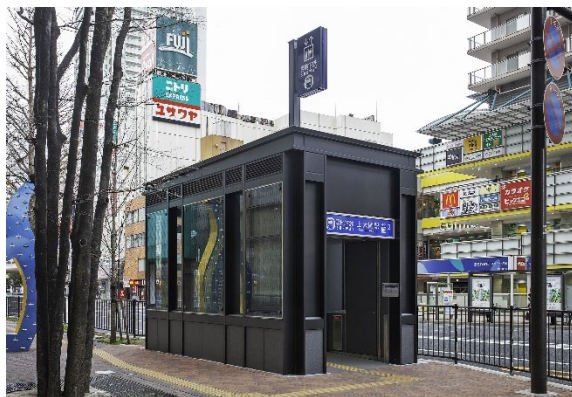
新設エレベーター（令和5年7月完成）
