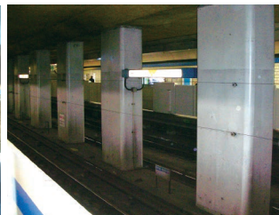
トンネル柱耐震補強▲
