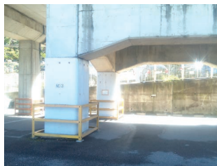
橋脚耐震補強▲
