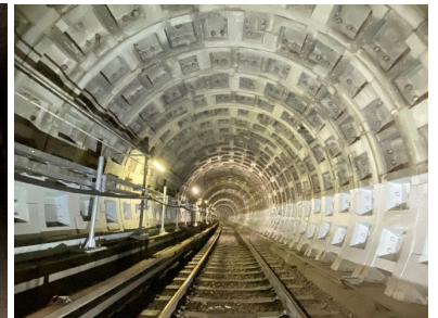
▲シールドトンネル構築補修
