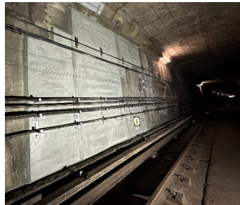
▲開削トンネル構築補修
