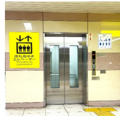
▲更新したエレベーター
