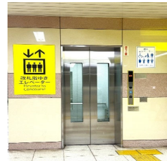
▲更新したエレベーター
