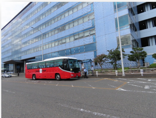
▲流通センターの4階まで避難します
