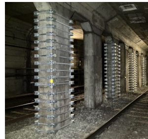
▲開削トンネル部
