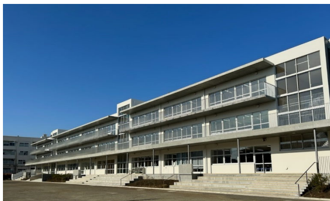
【建替校の一例】都岡小学校（旭区）の校舎棟外観、音楽室
