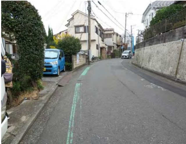
⑩三ツ沢東町6から松ヶ丘78 (豊頭寺線から六角橋第461号線への接続付近まで)
