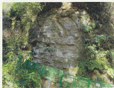
【岩接着施工後】
