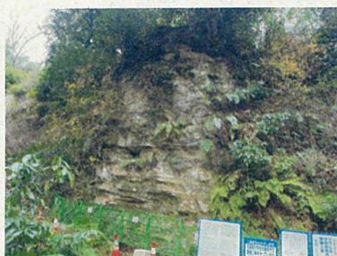
【岩接着施工前】
