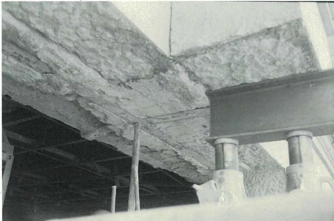
写真 17 錠聯鉄構法の参考例（旧横浜正金銀行本店本館） 昭和 41 年に神奈川県立博物館への改修工事中の写真（株式会社国設計所蔵）
