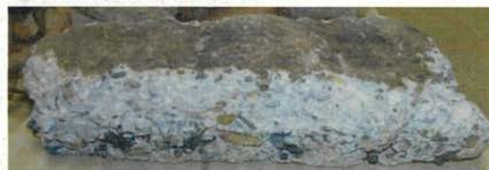
屋根スラブの断片
