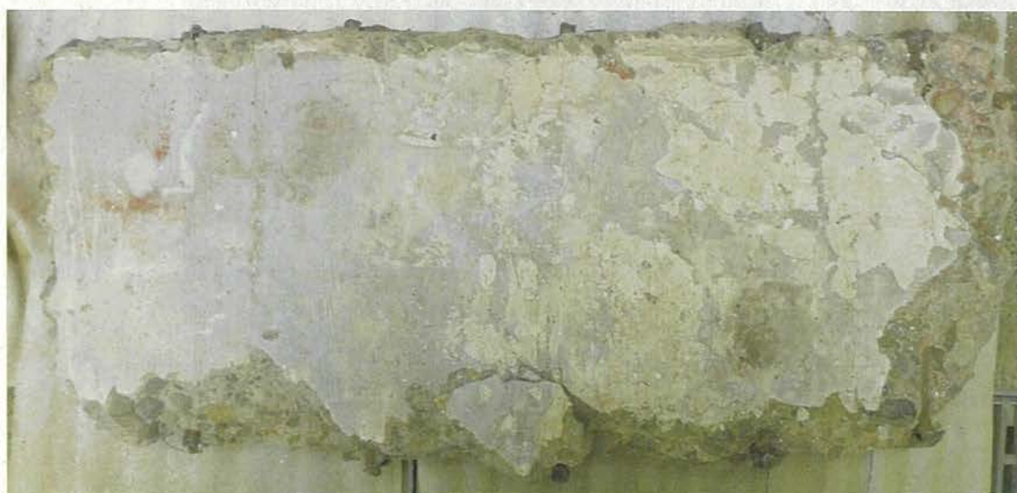
写真 10 旧三井物産横浜支店倉庫部材 屋根スラブ片 下面
