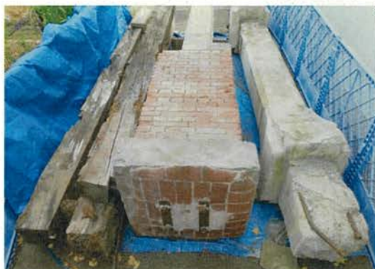
（左から）床梁、床大引、地階部及び1階部の柱切断片、1階上部の柱および2階部の柱切断片
