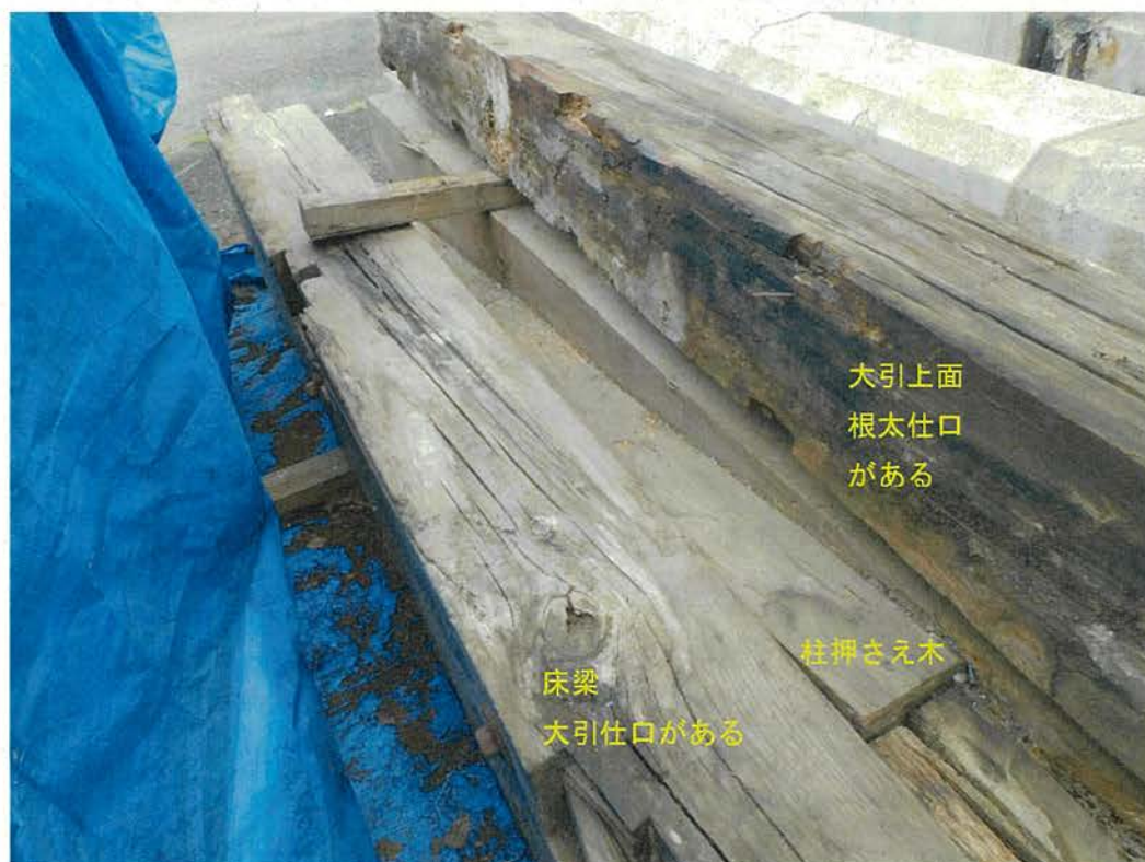
写真 12 旧三井物産横浜支店倉庫部材 床梁と「柱押さえ木」および大引 2025 年撮影
