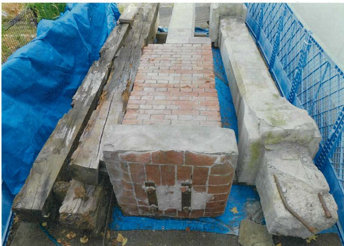
写真 6 埋蔵文化財センターにおける旧三井物産横浜支店倉庫部材の屋外保存状態 2025 年撮影 木部の腐朽が進んでいるので、一刻も早く保存措置が必要
