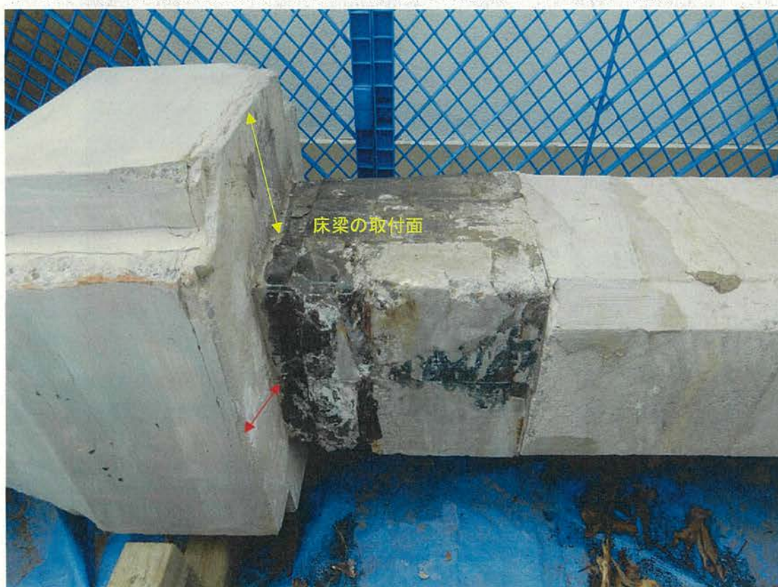
写真 14 旧三井物産横浜支店倉庫部材 1階柱頂部 黄色矢印部は赤矢印部より広い 2025 年撮影
