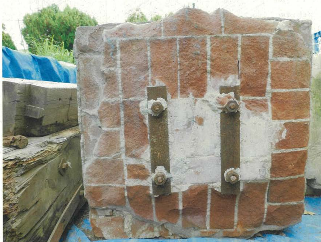
写真 18 旧三井物産横浜支店倉庫部材 地階柱 足元基台部の詳細
