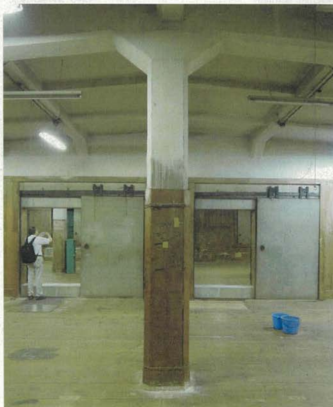
写真5 同上 3階柱と屋根梁・屋根スラブ 2013年撮影
