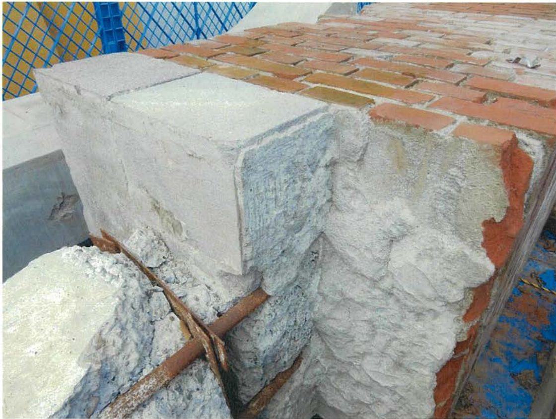
写真 15 旧三井物産横浜支店倉庫部材 地階柱 煉瓦積柱頂部の詳細
