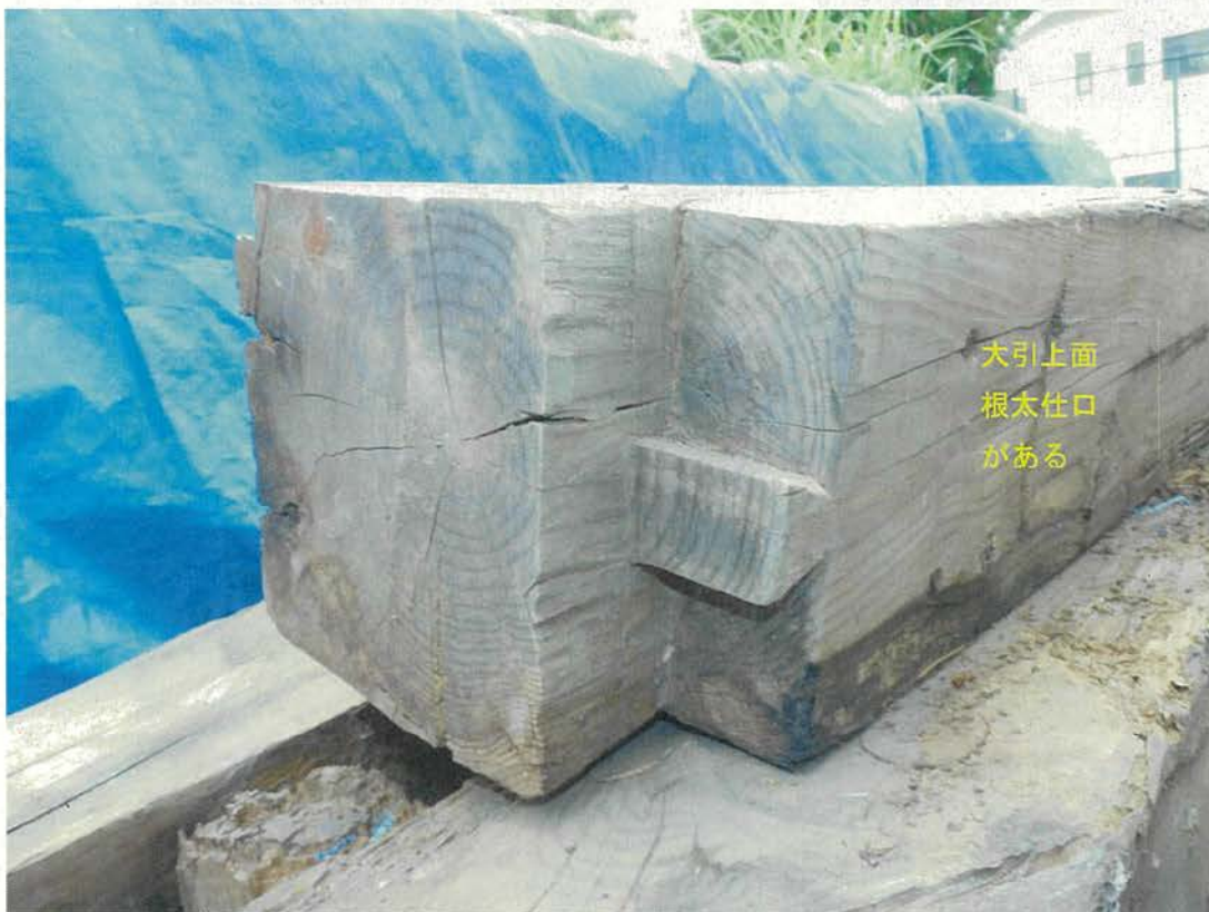
写真 13 旧三井物産横浜支店倉庫部材 大引端部の兜蟻仕口 2025 年撮影
