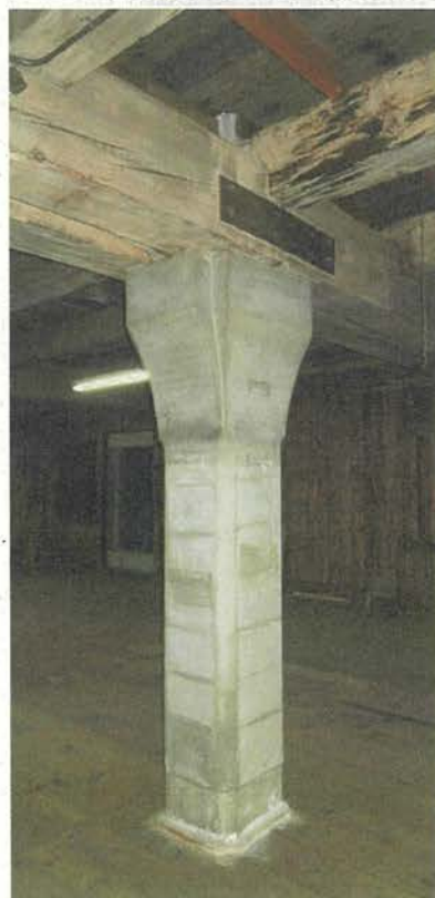
写真4 同上 2階柱と3階床組
