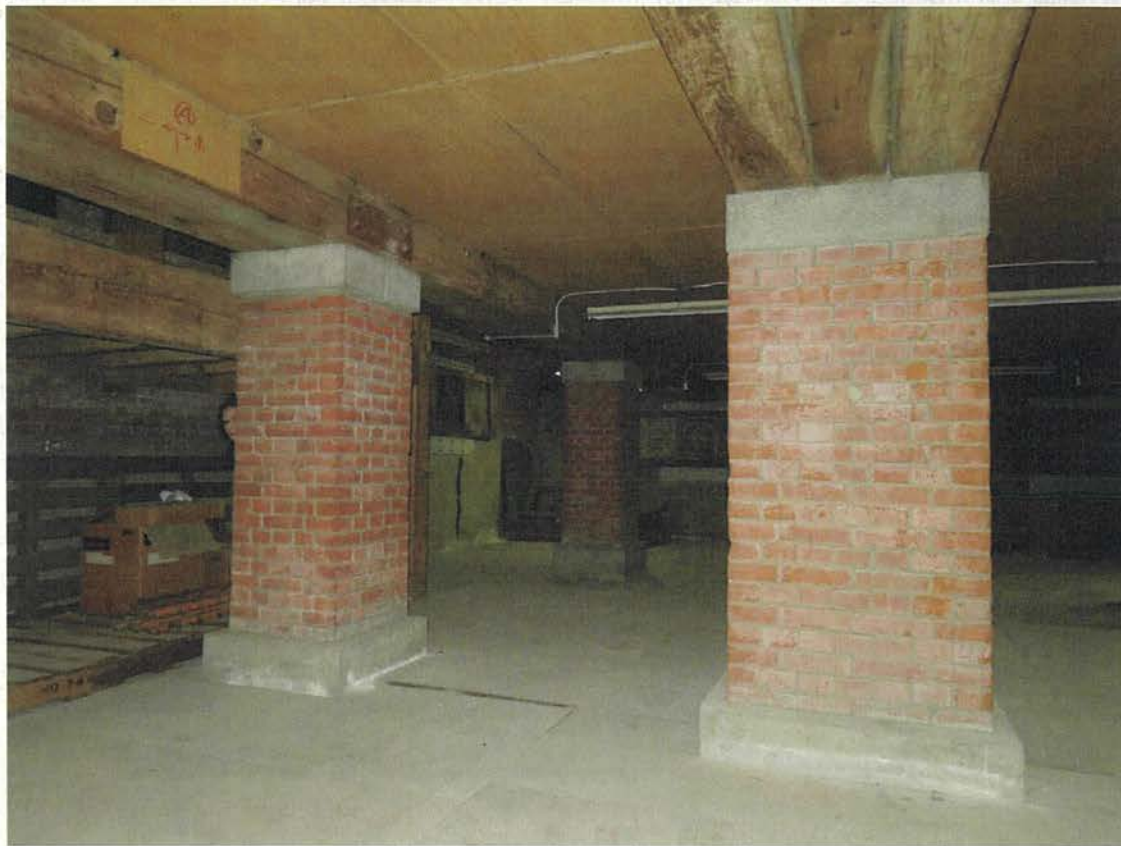
写真3 旧三井物産横浜支店倉庫 地階 右は柱、左は床束
