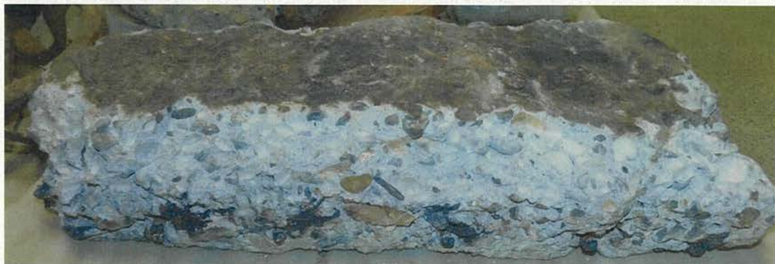
写真 8 旧三井物産横浜支店倉庫部材 屋根スラブ片 断面 2025 年撮影
