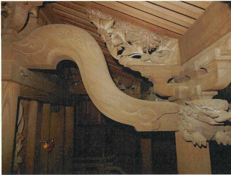
篠塚八幡社本殿 庇側面
