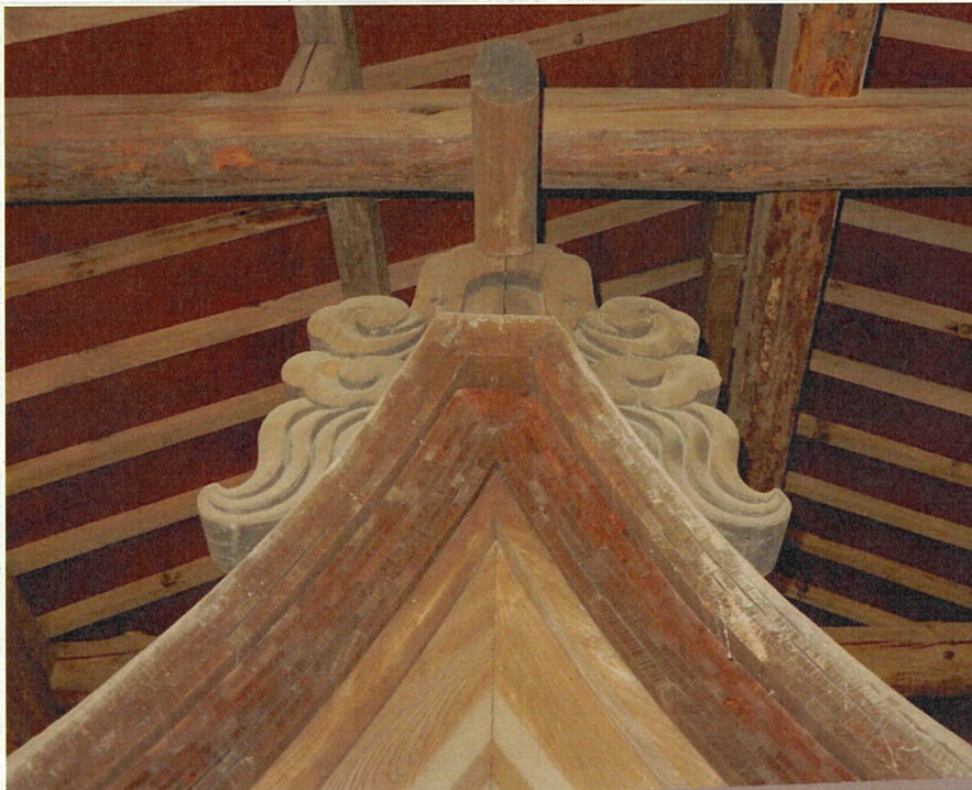
篠塚八幡社本殿 柿葺屋根の軒付拝み部分と鬼板・樋棟
