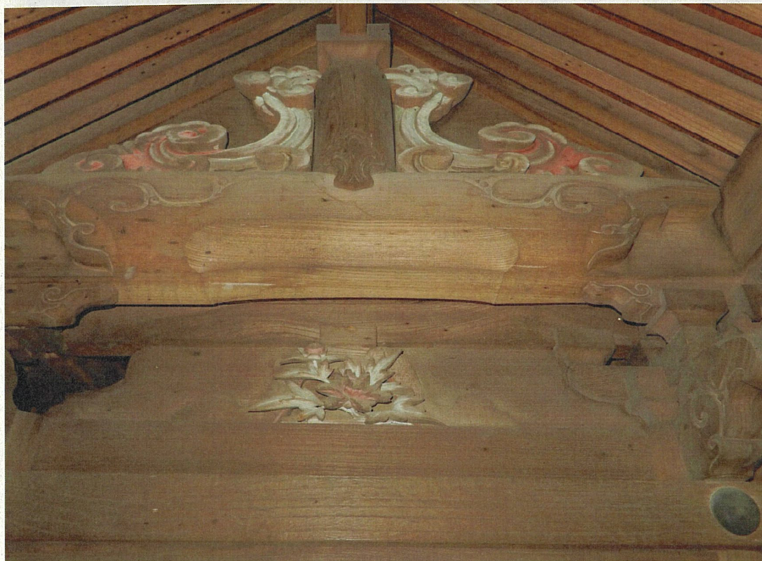
坂本第六社 本殿 身舎中備および妻組（西側面）
