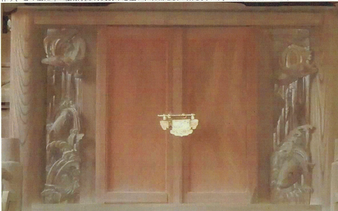
松尾神社本殿 身舎正面扉と小脇板
