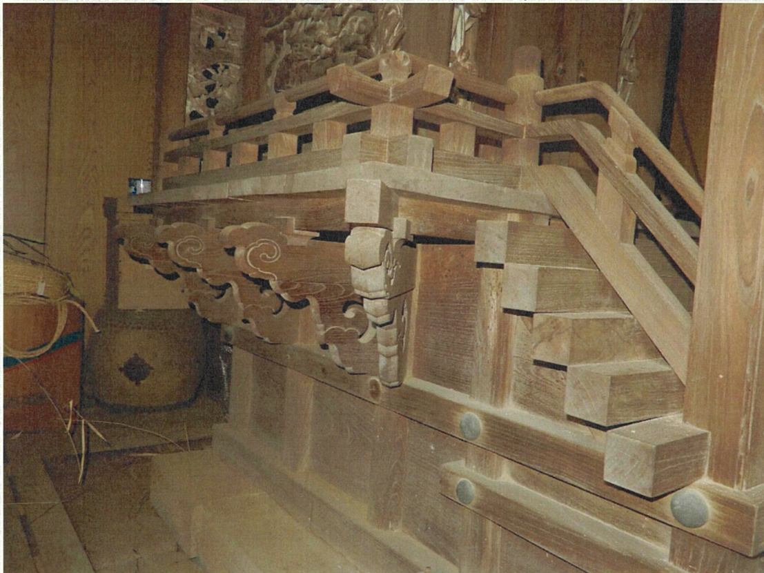
坂本第六社 本殿 庇の木階および登高欄、身舎の跳高欄付縁
