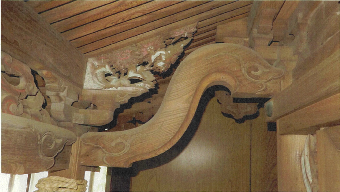
坂本第六社 本殿 庇の海老虹梁・手挟と身舎組物
