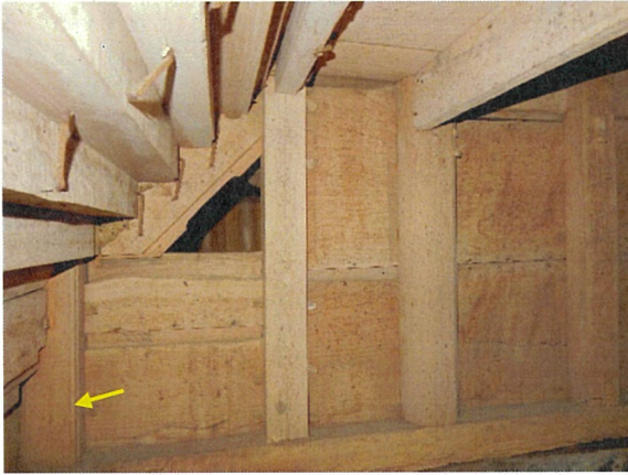
篠塚八幡社本殿 内部（庇部分と身舎境） 土台は身舎庇一連で矩形枠に組んでいる。庇柱は足元の見え隠れまで唐戸面を施している（→）。
