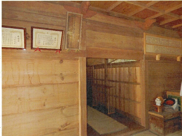
篠塚八幡社拝殿 棟札保管状況(保管箱で掲示)
