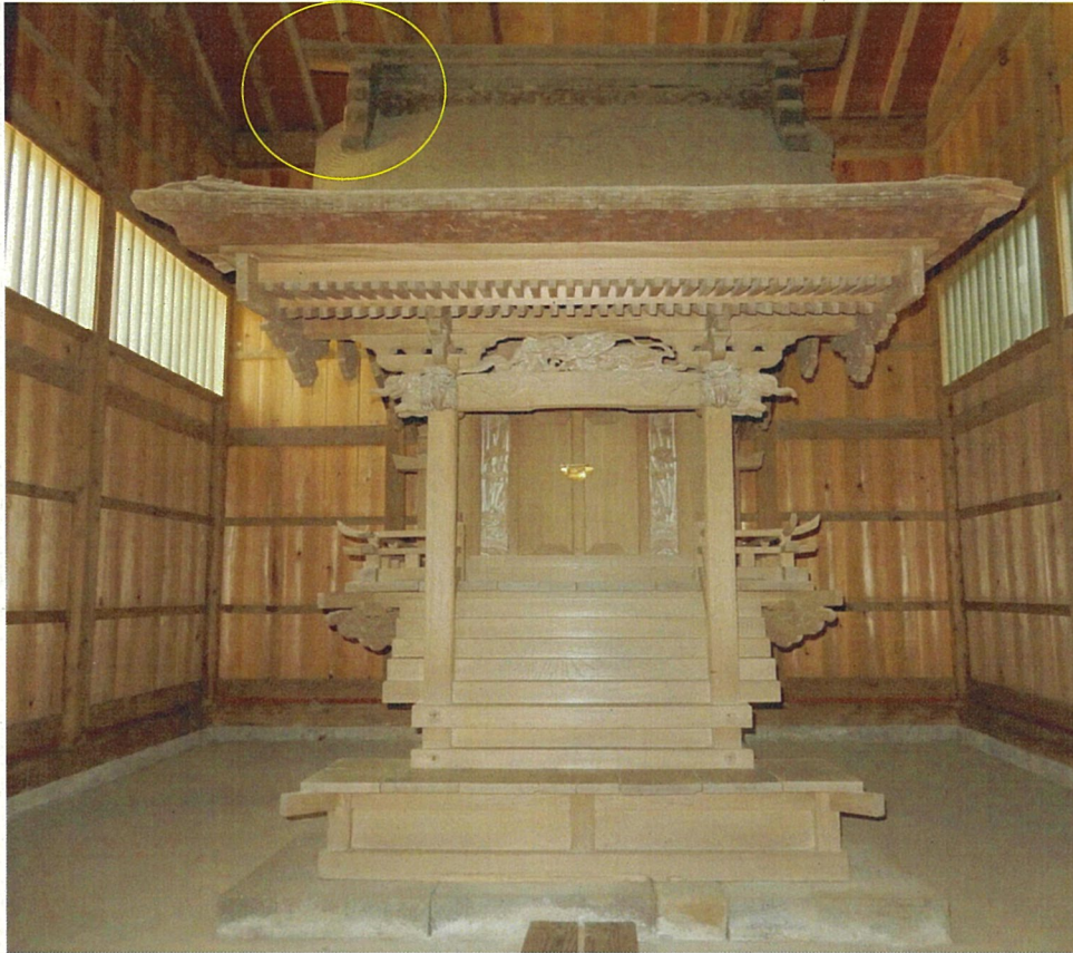
篠塚八幡社本殿 正面全景
