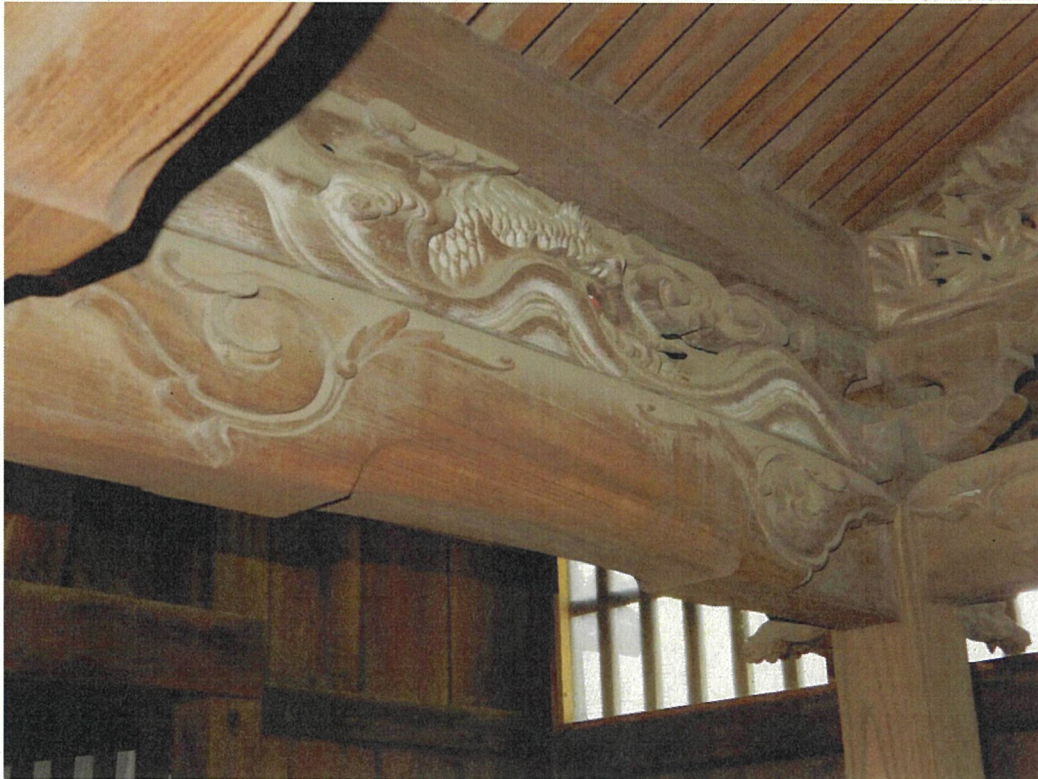
松尾神社本殿 庇虹梁見返し
