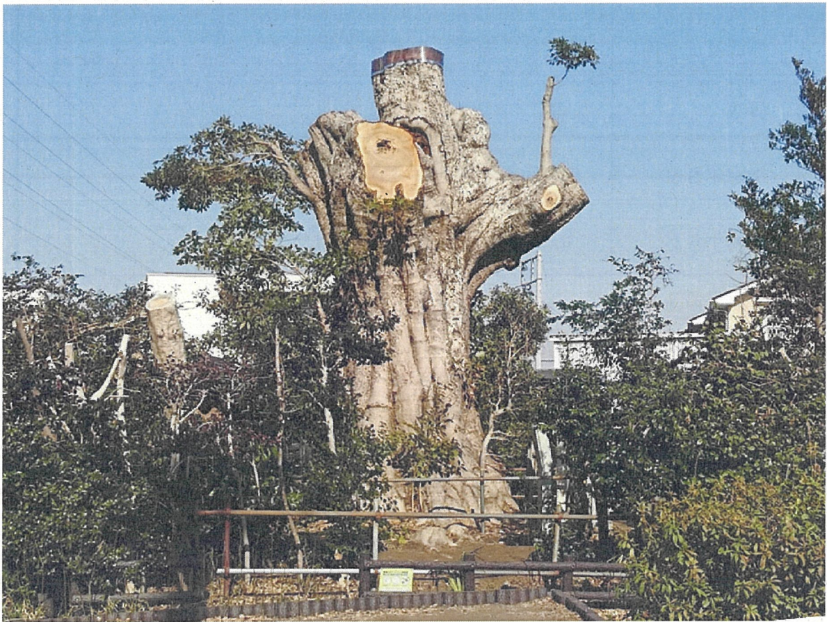
○伐採後の状況
