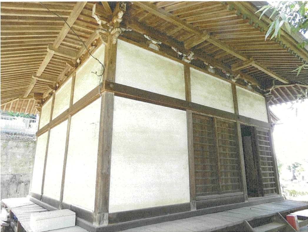
側背面 (南東側)
