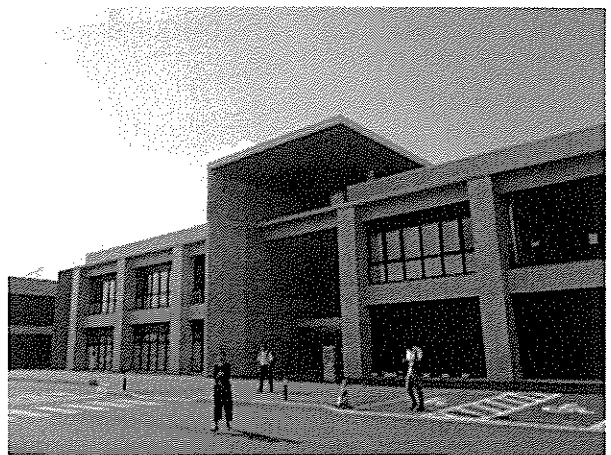
【環境創造センター】 外観
