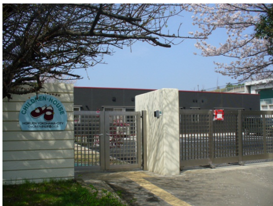
港北水再生センター（港北区大倉山）
