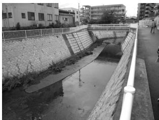
左岸から望む光明橋
