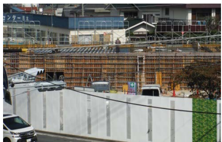
日限山地域ケアプラザ建設中 平成 28 年開所予定。
