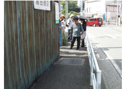
芹が谷中学校付近の狭い歩道 自転車も通り、歩行者の多い時間は大変危険。
