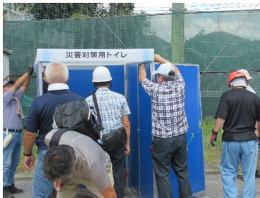
下水道直結式トイレ組立訓練
