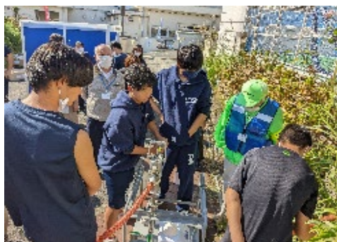
下水道直結式トイレ用の 送水ポンプの稼働確認
