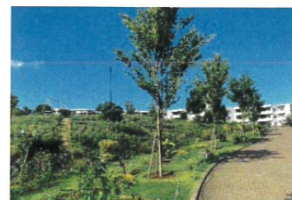
集合住宅の緑化(磯子3丁目地区)
