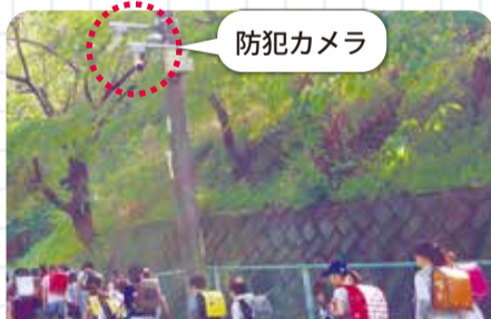
通学路に設置された防犯カメラ(岸根町町内会)
