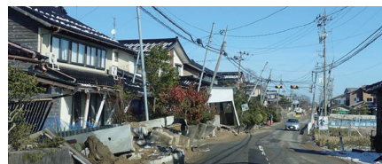
能登半島地震の被害状況(石川県ウェブサイトより)
