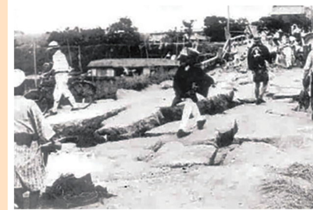
大綱橋付近の地割れの様子
