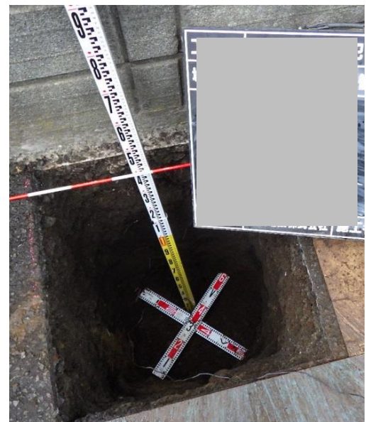
鋼管ポール設置工事の様子
