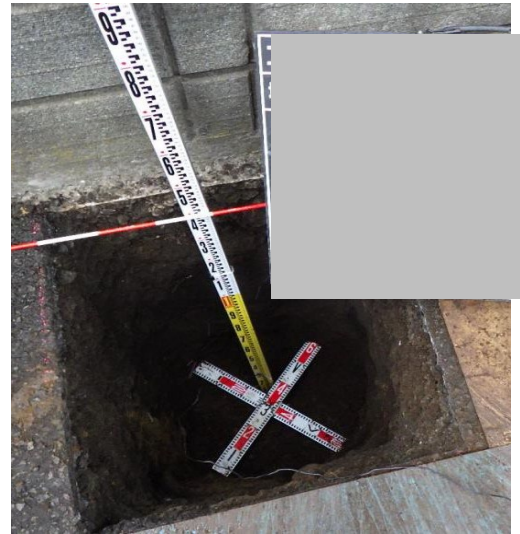
鋼管ポール設置工事の様子
