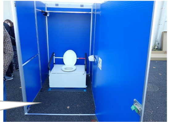
組立式仮設トイレの 設置
