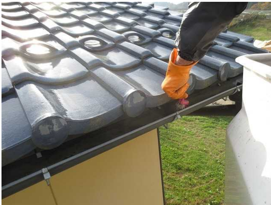
図 2-13 雨樋の除染の例（ブラシ洗浄）
