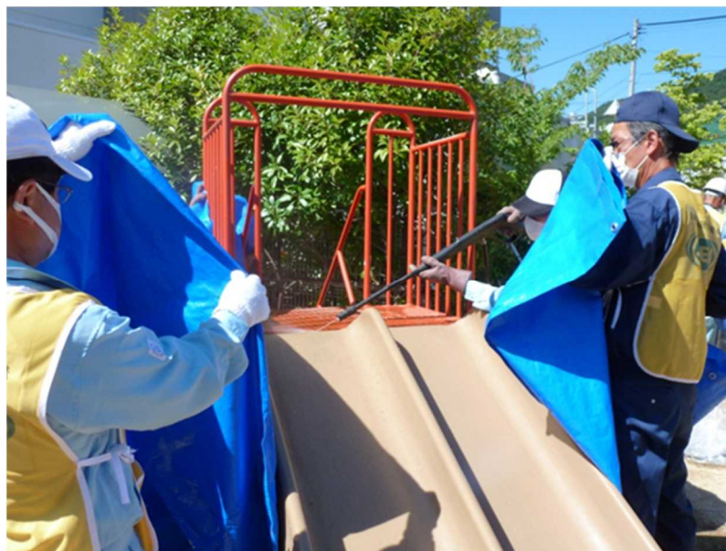
図 2-17 遊具の除染の例（高圧水洗浄）
