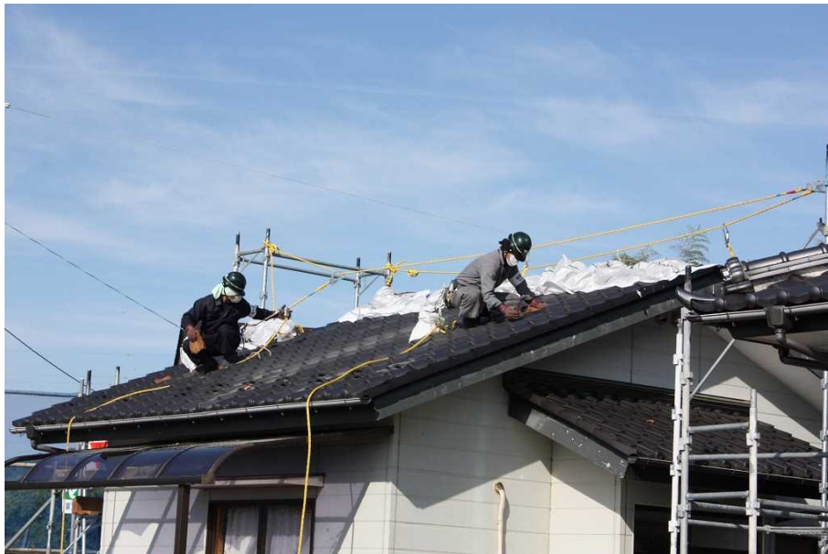
図2-9 屋根の瓦の除染の例（拭き取り）
