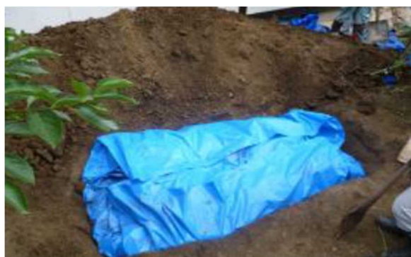
図4-6 現場保管（地下保管）例
