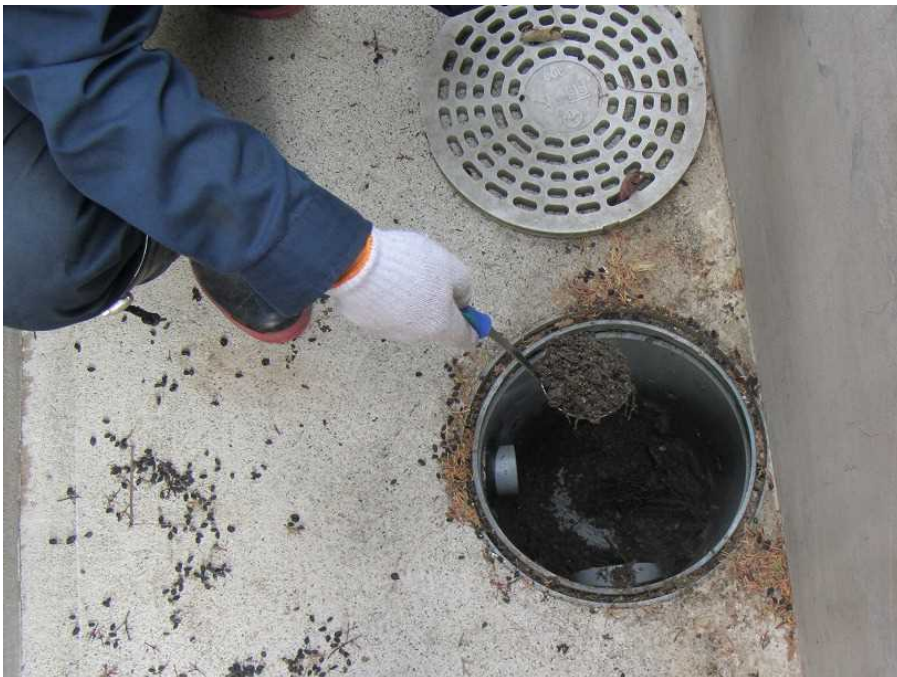
図 2-24 雨水枡の除染の例（堆積物の除去）
