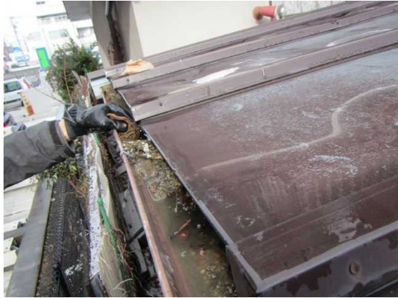
図 2-12 雨樋の除染の例（拭き取り）
