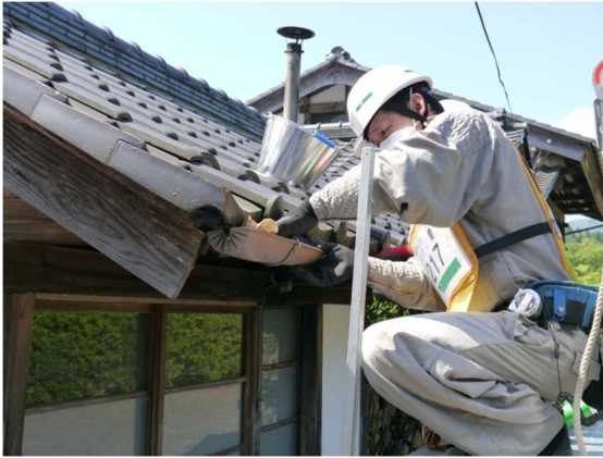
図 2-12 雨樋の除染の例（拭き取り）
