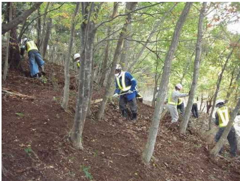
図 2-65 森林の除染の例（落葉等の堆積有機物の除去）
