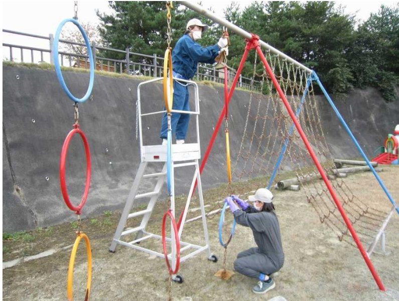
図 2-16 遊具の除染の例（拭き取り）
