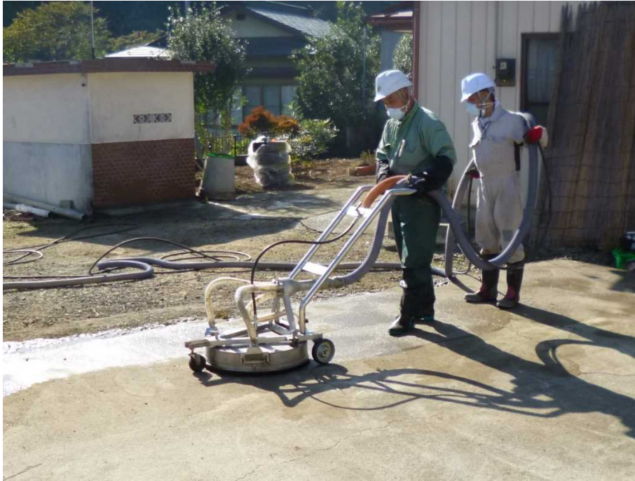
図 2-37 舗装面の除染の例（回収型高圧水洗浄）
