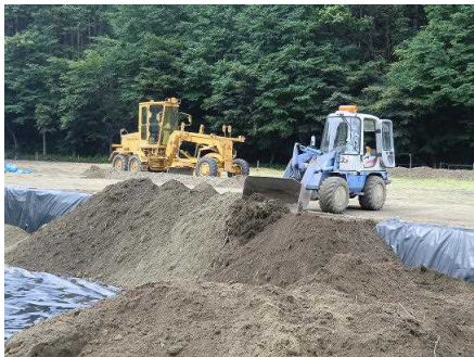
図4-9 現場保管（学校：地下保管）の例（写真提供：白河市）
