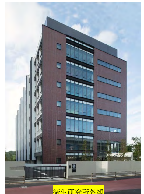
衛生研究所外観
