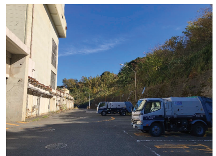
⑦計画地内の南側構内道路と法面をみる
