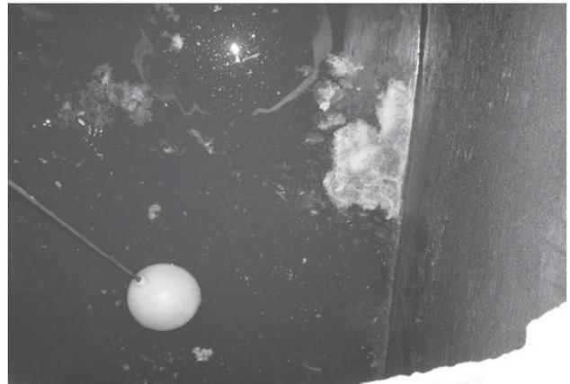
写真1 受水槽内の浮遊物。
