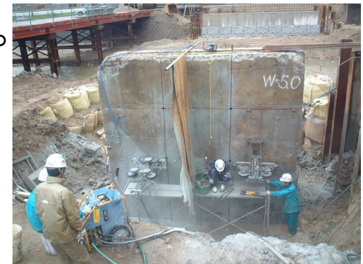
ワイヤーソー工法によるコンクリート構造物切断の例
