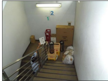
階段に物件が置かれている様子
