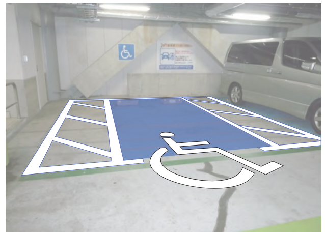
駐車スペースのみ青色を塗布し、目立たせている。 参考：横浜ベイクォーター（横浜市神奈川区）
