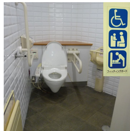
広めのトイレの表示 ：車いす使用者や子ども連れで利用できる広めトイレであることがわかるよう、扉にピクトグラムで表示しています。
