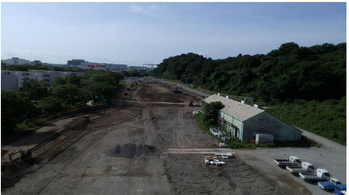
草地広場全景
