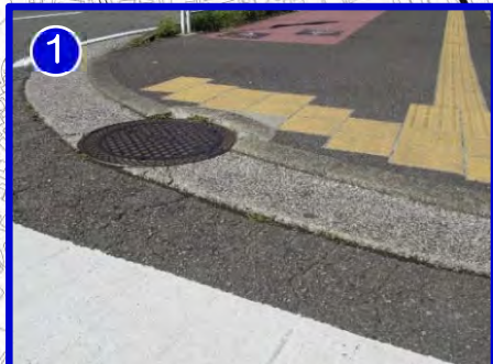
【杉田交番前交差点～ 新杉田公園前交差点間】 ●舗装の改修
